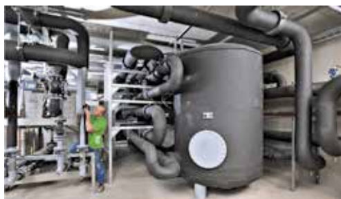
Příklad použití izolace NH/ArmaFlex Smart
